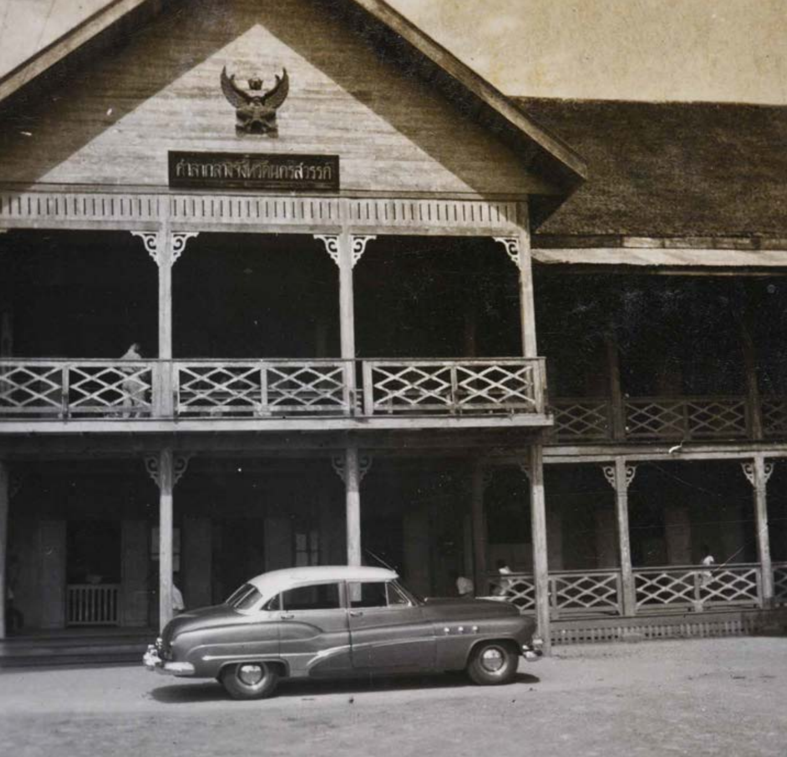
ศาลากลางจังหวัดนครสวรรค์ (หลังแรก) ภาพยุค ๒๔๙๐ ตั้งอยู่ริมถนนสวรรคร์วิถี เดิมเป็นศาลว่าการมณฑลนครสวรรค์ จนถึง พ.ศ. ๒๔๗๖ จึงใช้เป็นศาลากลางจังหวัด สังเกตว่ามีการต่อเติมมุขด้านหน้าอาคารเพิ่มเติมจากภาพหน้า ๕๘ (ภาพจากครอบครัวเวชประดิษฐ์)
