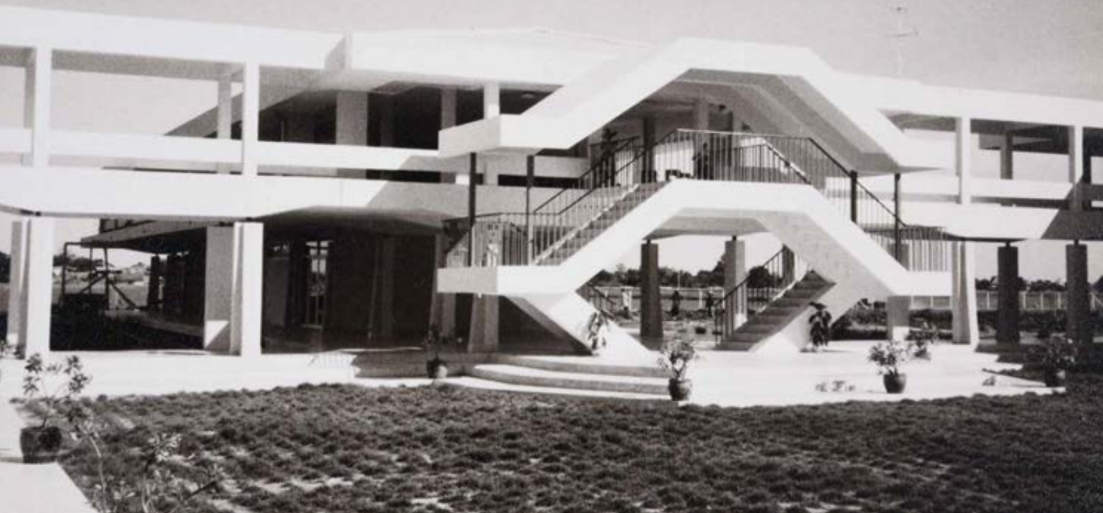
โรงเรียนนายอำเภอ (วิทยาลัยการปกครอง) ภาพถ่ายอาคารเมื่อแล้วเสร็จราว พ.ศ. ๒๕๑๐ ตั้งอยู่ริมถนนรังสิต - นครนายก (คลอง ๖) อำเภอธัญบุรี จังหวัดปทุมธานี (ภาพจากบุตรและธิดาของนายถวิล สุนทรสารทูล)
